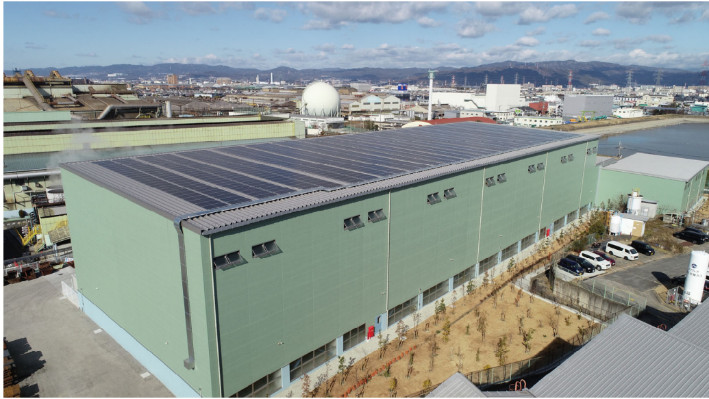
太陽光パネルの設置が完了した枚方事業所の製品倉庫
