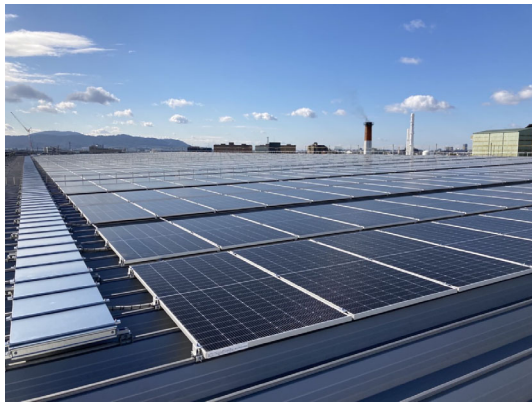
屋根上の太陽光パネル
