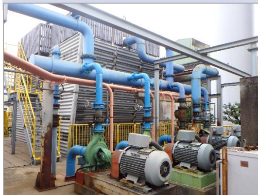
クローズドシステムの水処理設備
