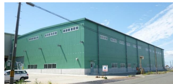
2019年に完成した製品倉庫 (山口)
