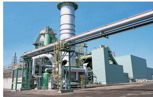
ガス化溶融炉
