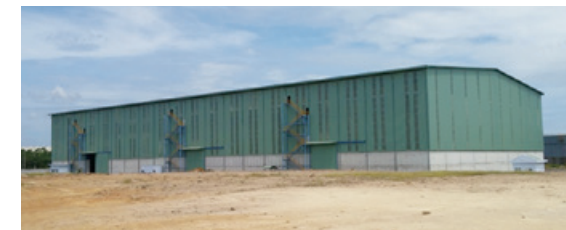
▲ 完成したVKS社専用倉庫
