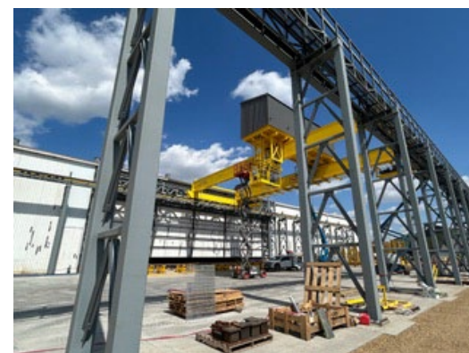
拡張工事が完了した出荷ヤード
