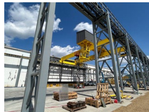
拡張工事が完了した出荷ヤード
