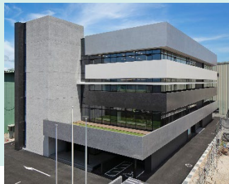
山口事業所新事務所棟
