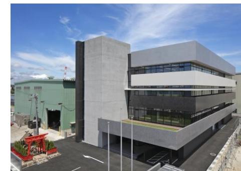
山口事業所新事務所棟
