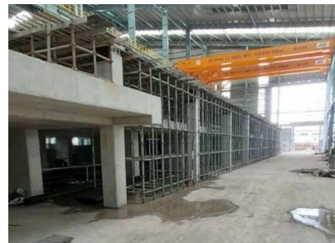
冷却床付近架台基礎
