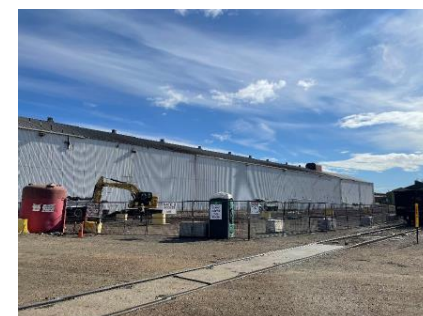
建設中の出荷ヤード
