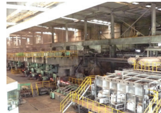
工場設備(圧延ライン)
