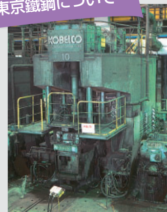
東京鐵鋼の圧延設備
