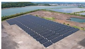
山口事業所の 太陽光発電設備
