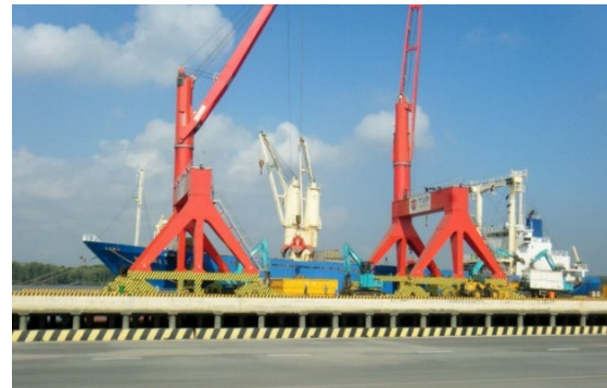
港湾設備(荷揚げ作業)
