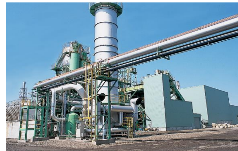
ガス化溶融炉
