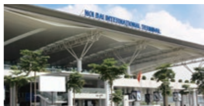
ベトナム ノイバイ国際空港(2020年の滑走路拡張工事にキョウエイ・スチール・ベトナム社の製品を納入)
