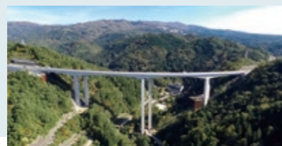
東海北陸自動車道驚見橋(高さ125mの橋脚を有する高架橋。高強度ネジ節鉄筋を多数納入)
