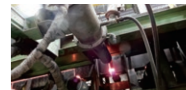
熱間表面疵検出装置
