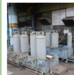
エアコンや冷凍冷蔵機器の冷媒として使用されるフロンガスの破壊処理から、他の破壊施設で敬遠されるSF6(六フッ化硫黄)やPFC(パーフルオロカーボン)、ハロンガスの処理に対応。地球温暖化防止に貢献しています。
